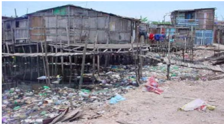
FIGURA 6. DEGRADAÇÃO AMBIENTAL E PRECARIIDADE DE MORADIA EM ALAGADOS. FONTE: CONDER
