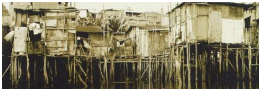
FIGURA 5. PALAFITAS NOS ALAGADOS ANOS 50. FONTE: CONDER
