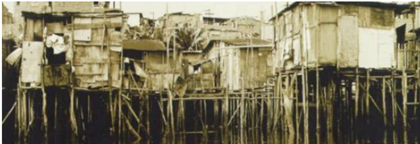
FIGURA 5. PALAFITAS NOS ALAGADOS ANOS 50. FONTE: CONDER
